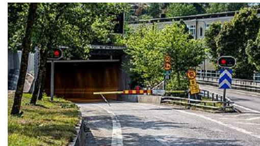
Exempel på utrustning för avstängning av en väg
