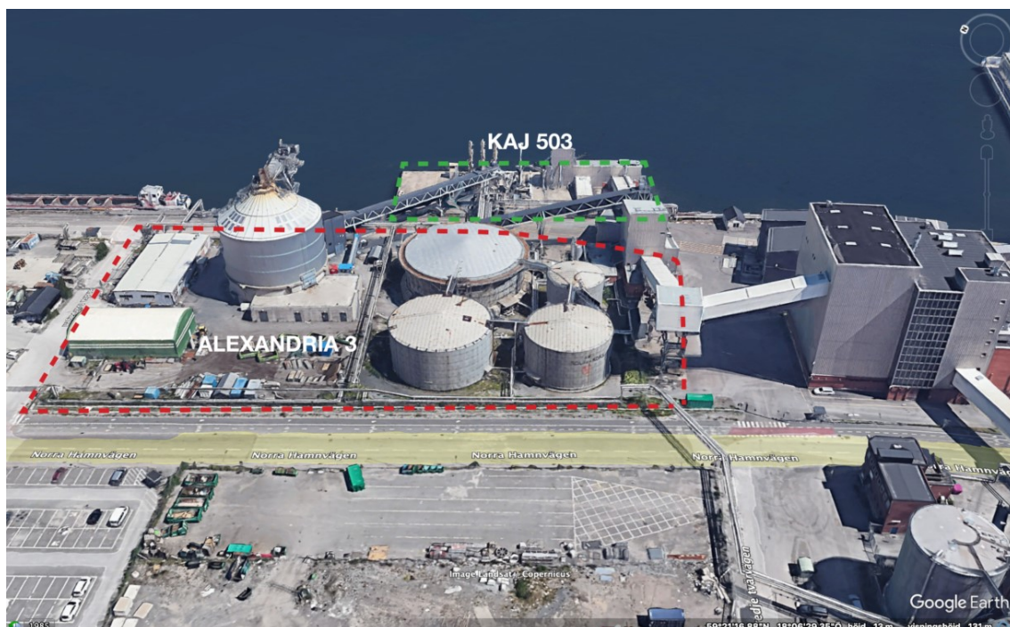
Figur 7. Befintliga anläggningar på Alexandria 3 och kaj 503. © Google
