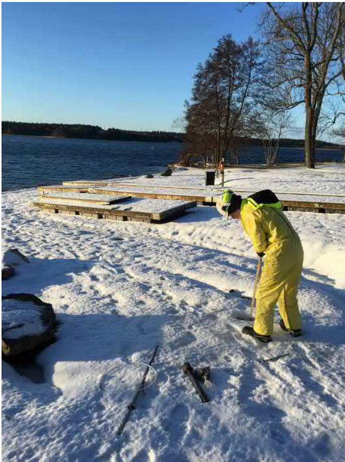
Figur 1. Badstrand väster om småbåtshamnen, Lövsta. Provpunkt 18S409 (utgick). Provpunkt 18S410 strax utanför bild på andra sidan den upplagda bryggan. Stålspjut och slidhammare för neddrivning av porgasspetsar.
