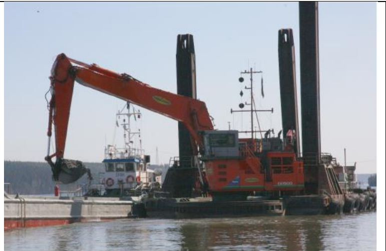
Bild 4.1. Medelstort enskopeverk. Muddring i Södertälje Sydhamn med liten partikelspridning. Foto. KFS
