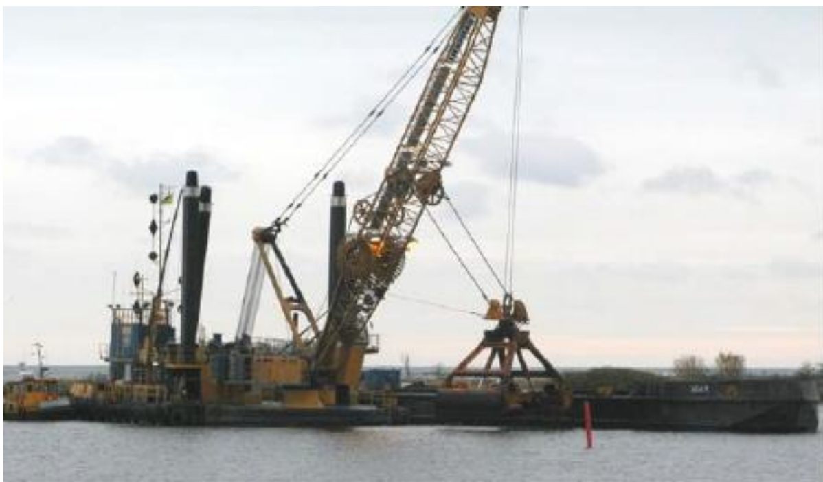
Figur. Pågående muddring i Åhus hamn med horisontalskopa HPG (miljöskopa). Foto KFS
