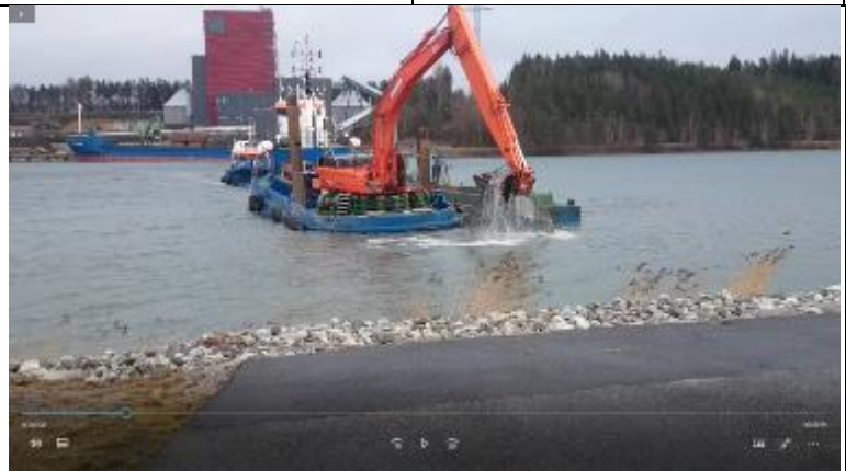
Bild 4.4. Underhållsmuddring i Södertälje Bränlehamn med liten partikelspridning betydligt under tillåtet begränsningsvärde Foto KFS
