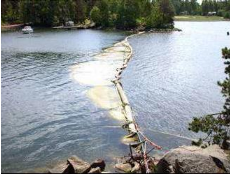
Figur 6.3. Siltskärm påverkad av ström. Örserumsprojektet i Sverige. Referens 5.
