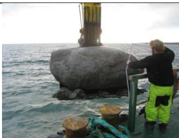
Bild 4.6.Enskopeverk. 7,2 \text{ m}^3 block Foto Boskalis
