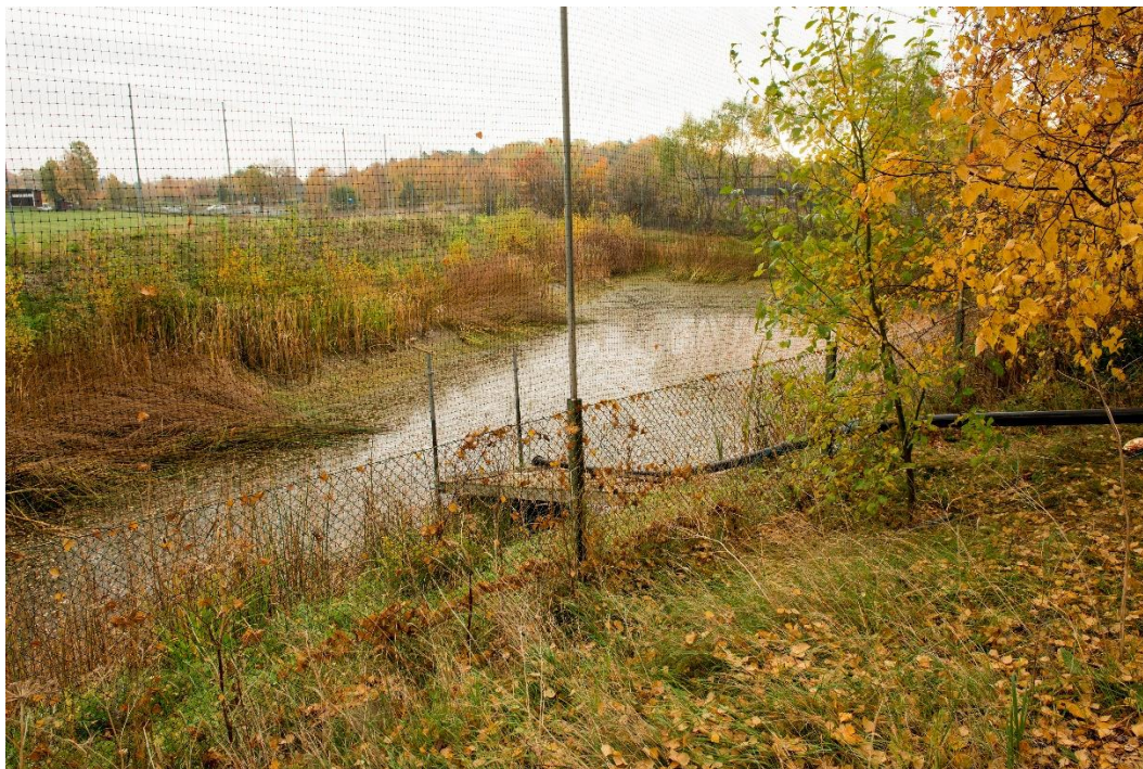
Figur 4. Damm D1 sedd från nordväst. Dammen omges av ett högt stängsel.
