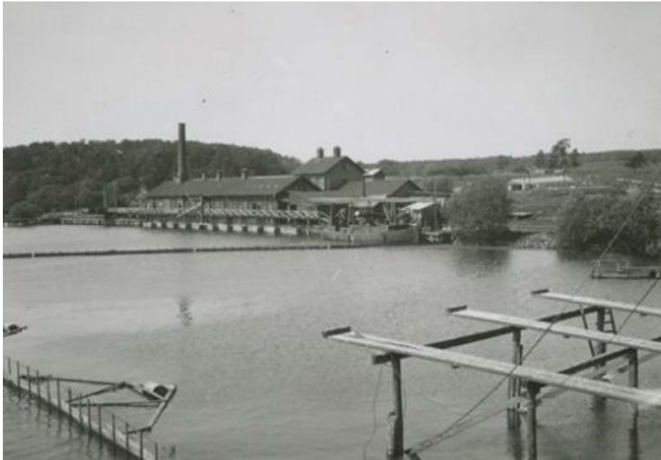
På platsen för dagens båtklubb låg Lövstas latrinstation och pudretfabrik. I förgrunden syns lastbryggor för sållsopor. I vänstra hörnet syns den läns som förhindrade sopor att sprida sig i Mälaren. Lövsta 1937. Digitalt stadsmuseum. Fotograf: John Söderberg.
