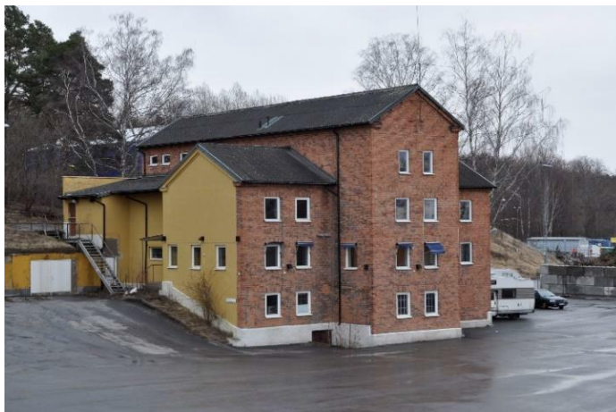
Den första sopförbränningsanläggningen från 1911 och som senare användes som kontor. Den västra gaveln i gul puts var hopbyggd med förbränningsugn och skyddsrum, vars byggnadsdelar revs 2006
