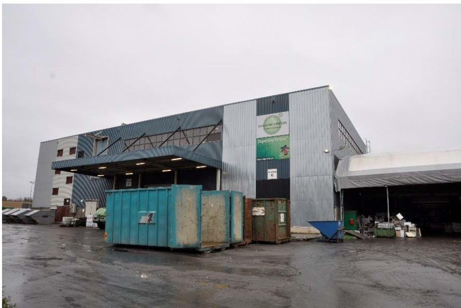
Byggnaden för automatisk materialåtervinning från 1970. Byggnaden används idag för freonåtervinning. Rör och transportband har rivits (jmf. Bild från 2003 ovan)
