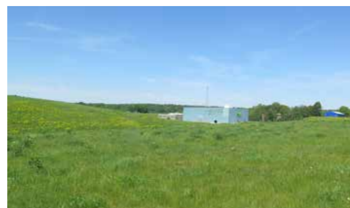
Teknikanläggningar som döljs bakom deponikullarna.
