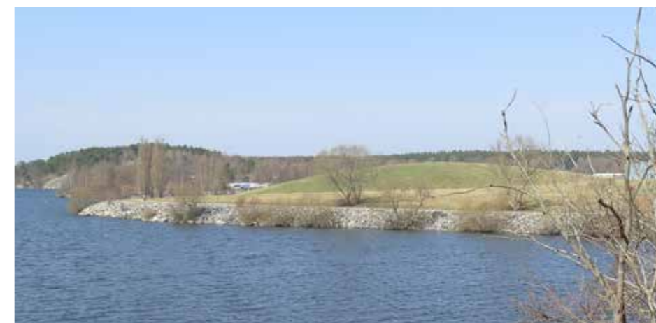
Deponikullarna, rester från tidigare sopanläggning
