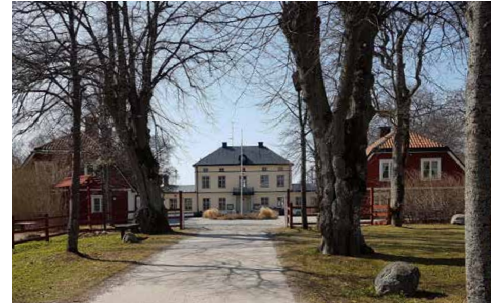
Dagens Riddersvik med huvudbyggnad och flyglar, uppförda 1762. 1810 byggdes huvudbyggnaden till med två lägre sidobyggnader. På platsen låg här tidigare torpet Flottvik eller Flåt wik som lydde under Lövsta by. Två alléer leder fram till byggnadens entré, en från landsidan och en från sjösidan. Idag används Riddersvik som hotell och konferensanläggning. Till gården hörde stall, vagnshus, källare, hönshus, vedbod och en iskällare.
