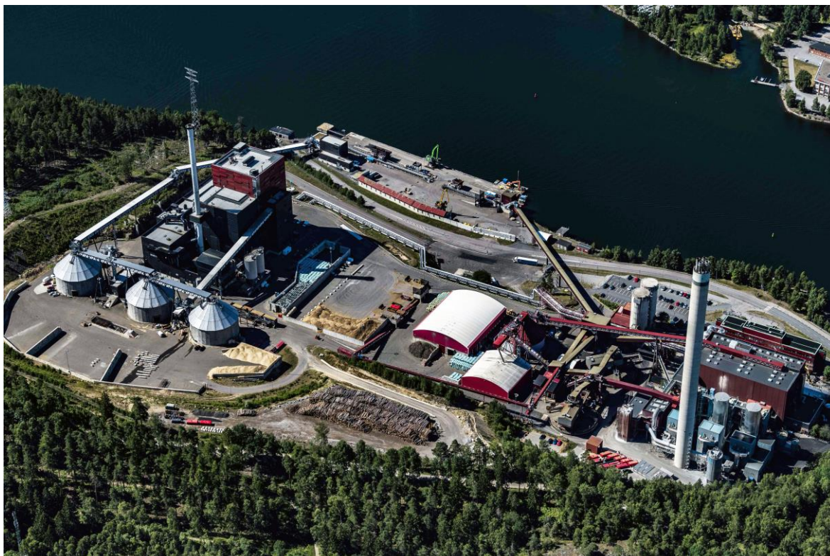
Figur 4. Igelstaverket, Södertälje. Källa: Söderenergi
