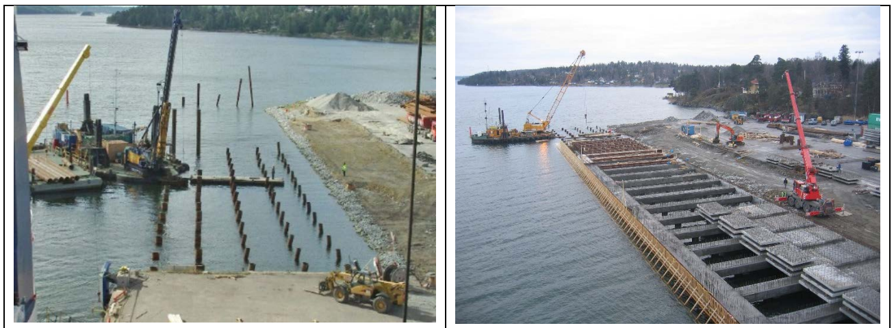
Figur 12.2. Jämförbar uppbyggnad av kaj. Installation av grova stålörspålar genom fyllning och erosionskydd, vänstra bilden. Pålning avslutad och uppbyggnad av kajdäcket i betong, högra bilden. Foton KFS.
