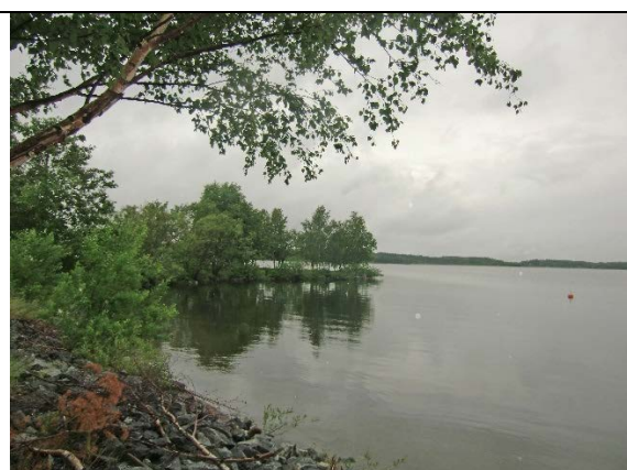
Figur 6.8. På den finkorniga fyllningen finns från år 2010 utlagt en stenfyllning från släntrön ungefär ner till vattenlinjen. Foto KFS 25 juni 2012.
