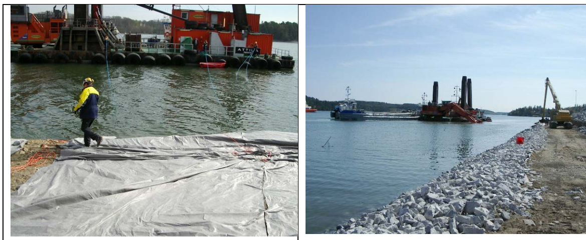
Figur 9.9. Exempel på avlastat slänkrön, utläggning av bergfyllning och erosionskydd vid slänfot och på större djup upp längs slänten med hjälp av mudderverk, som här hämtar bergmaterialet ur pråm. En grävmaskin med långsticka nyttjas i detta fall för att utföra arbetet i den övre delen av slänten.
