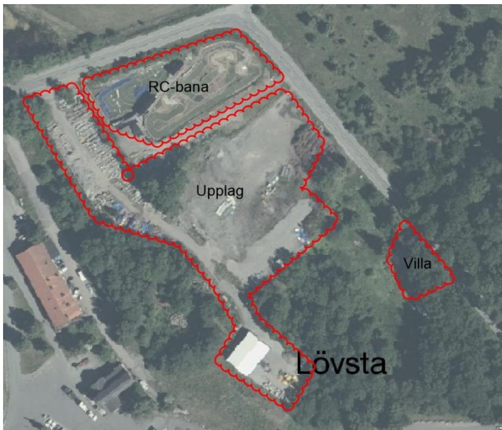
Figur 6. Befintliga konstruktioner i det övre planets område där kraftvärmeverket planeras att anläggas.
