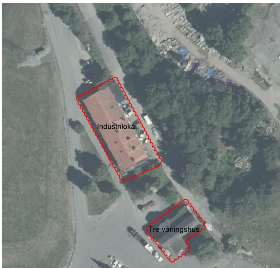
Figur 9. Befintliga konstruktioner där silorna 1–6 planeras att anläggas.
